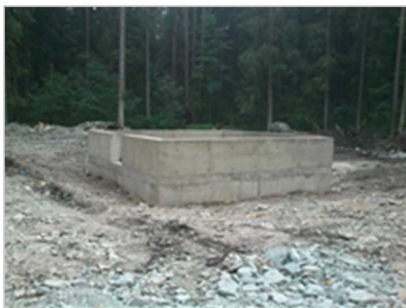
Joonis 5. Näide tuulutussurfi rajamisest ja olukorrast talvel. Allikas: Enefit Kaevandused AS
