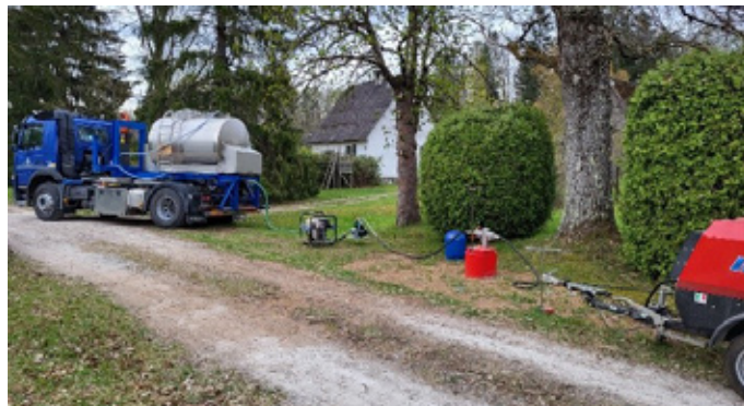
Ühisveevärgi jaotustorustiku läbipesu hüdropneumaatilisel meetodil.
