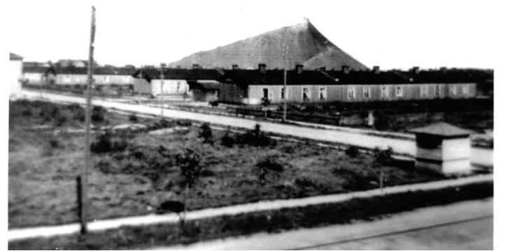
Vaade veetorni otsast. Kiviõli linna fotokogu. Autor teadmata. Kiri foto tagaküljel: Kiviõli 1962. Pildi keskel Kauba tänav ning Aasa 13 ja Aasa 11. Täna kolme kaupluse, Coop, OG Elektra ja K5, asemel olid barakid.
