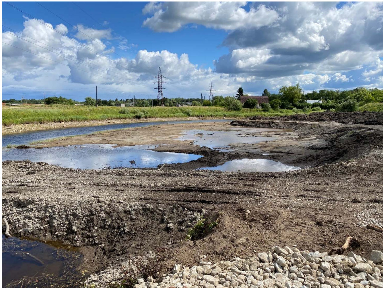
Foto 7. Püssi paisjärv puhastustööde järgselt, alandatud veetasemega (Inseneriehituse AS, 23.07.2020).
