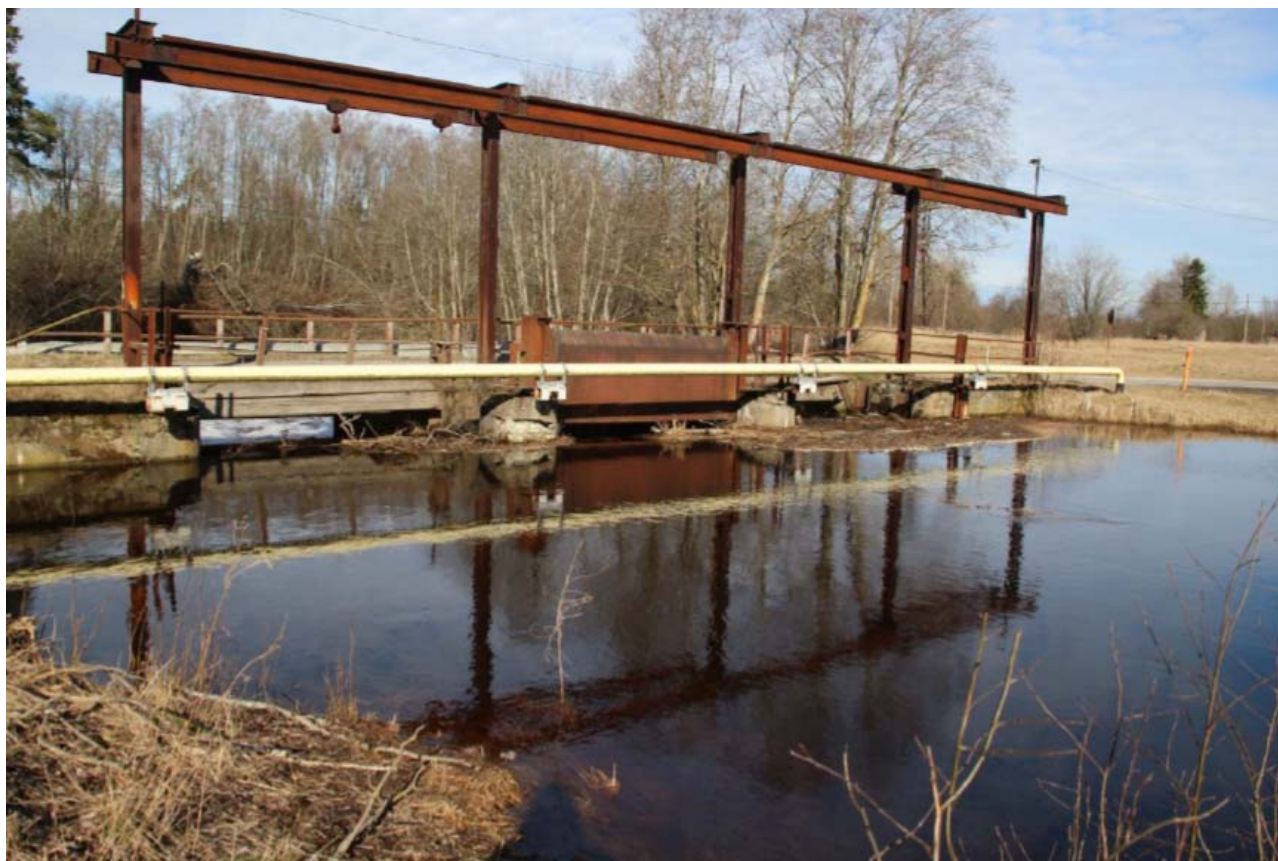
Foto 6. Vaade sillale ja paisule Püssi paisjärve lõunakaldalt (Ekspertiis ja Projekt OÜ, 2020).
