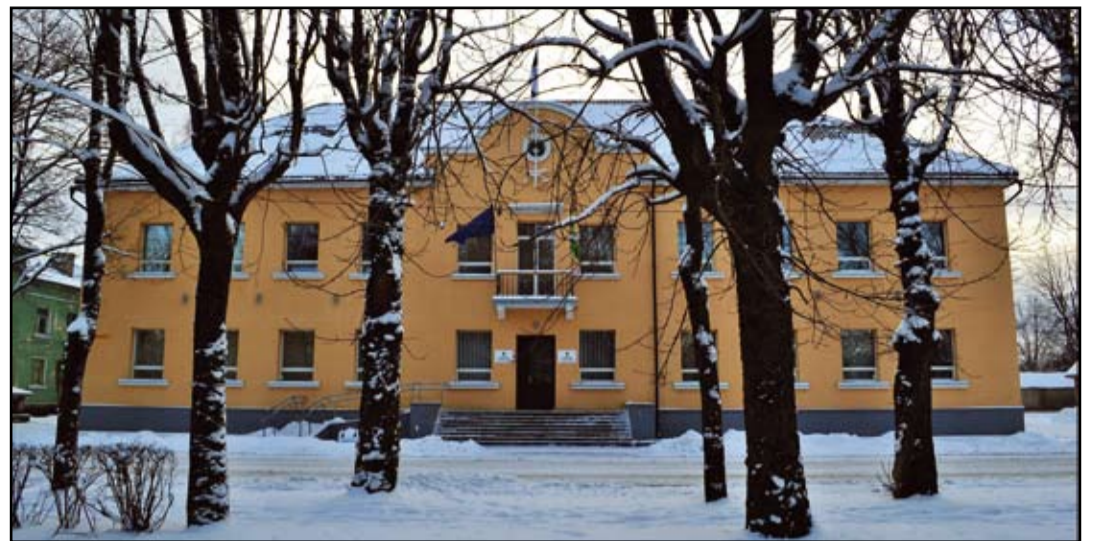
Lüganuse vallavalitsuse teise korruse kasutamata ossa ehitatakse ametnikele tööruumid.
